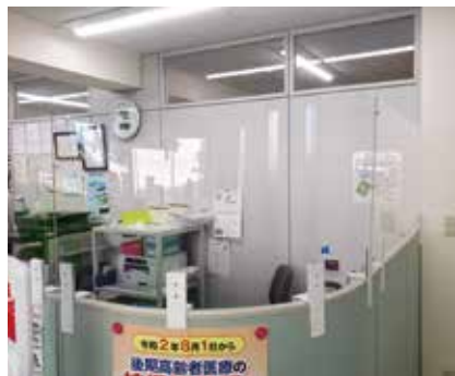
既存のパーティション上部にアクリルを追加。曲面にも対応。
