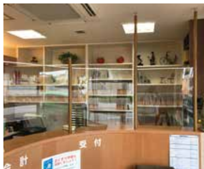
天井とカウンターを木製柱でつっぱり、柱にアクリル板を差し込んだタイプです。
