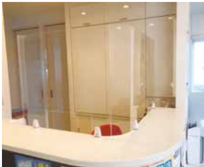
L型カウンターに沿って加工・取付しました。
